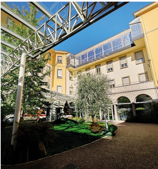
La casa di cura «Beato Palazzolo» in via San Bernardino
