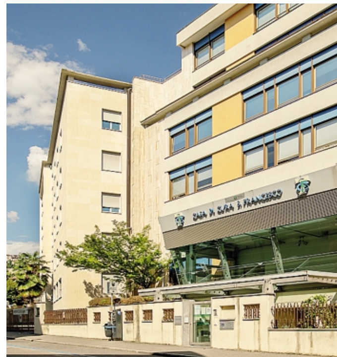
La casa di cura «San Francesco» in via IV Novembre
